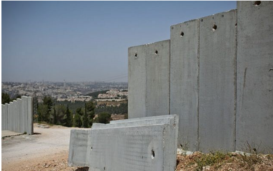
La barrera de seguridad entre Israel y la Cisjordania bajo construcción. Foto Noemi Moskowitz
